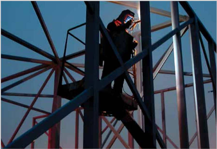
Minarc 220 para soldadura MMA en obra
